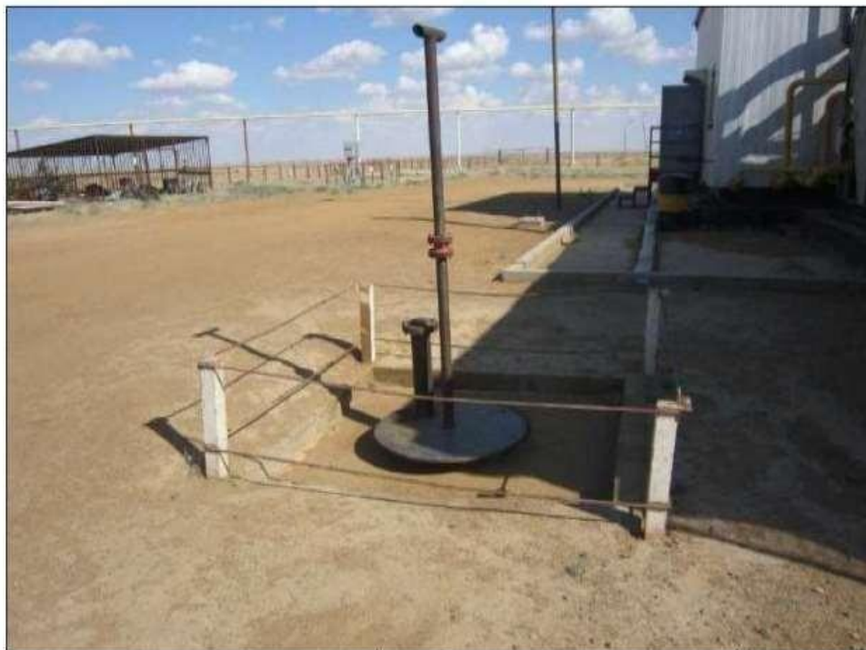
Фото 2.8. Подземная емкость временного хранения отработанного масла
