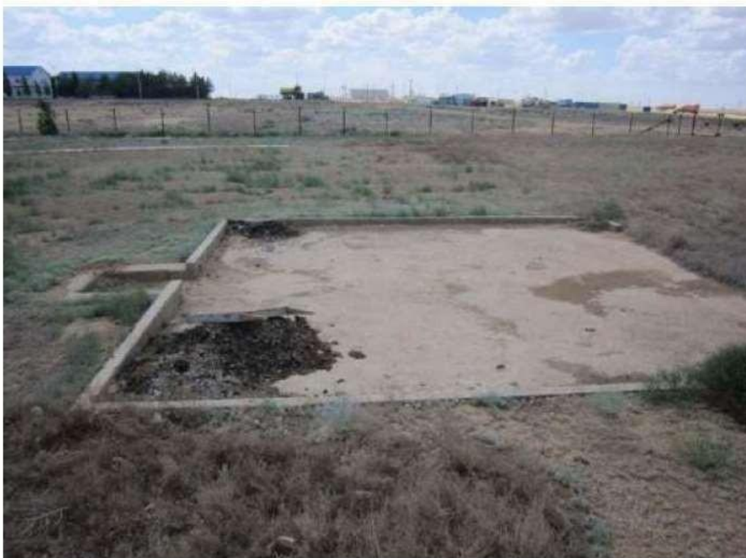
Фото 2.4. Площадка для компостирования илового осадка на очистных сооружениях
