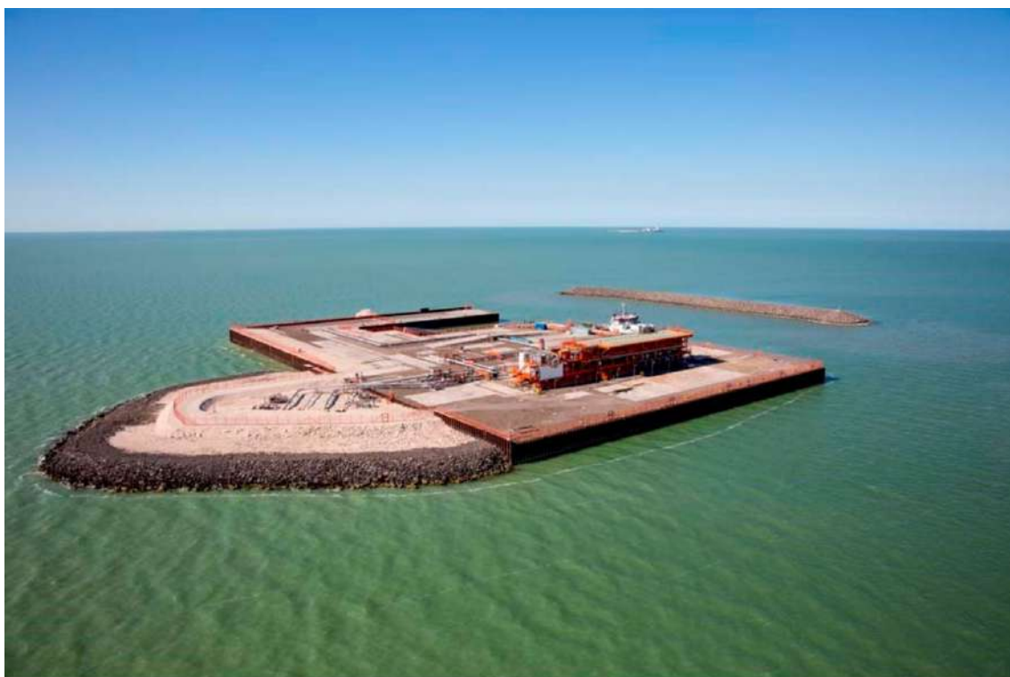
Рисунок 2.2.1.9 Остров ЕРС3. Общий вид
