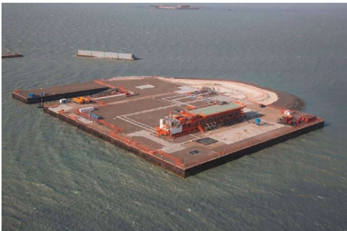
Рисунок 2.2.1.8 Остров ЕРС2. Общий вид
