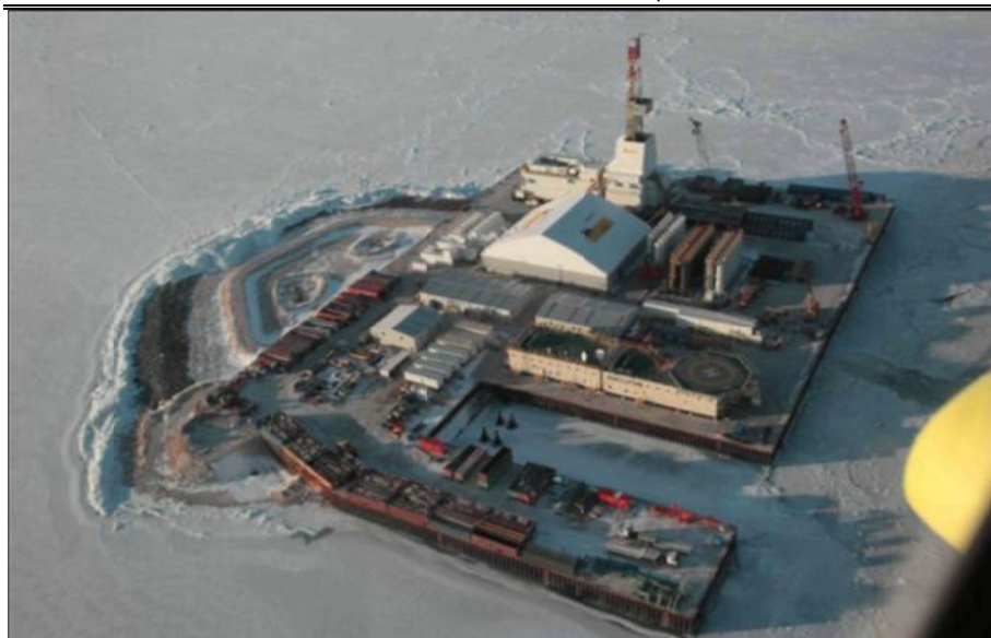
Рисунок 4.2.2-2 Ледовое воздействие на существующую насыпь ЕРС2 (декабрь 2011)
