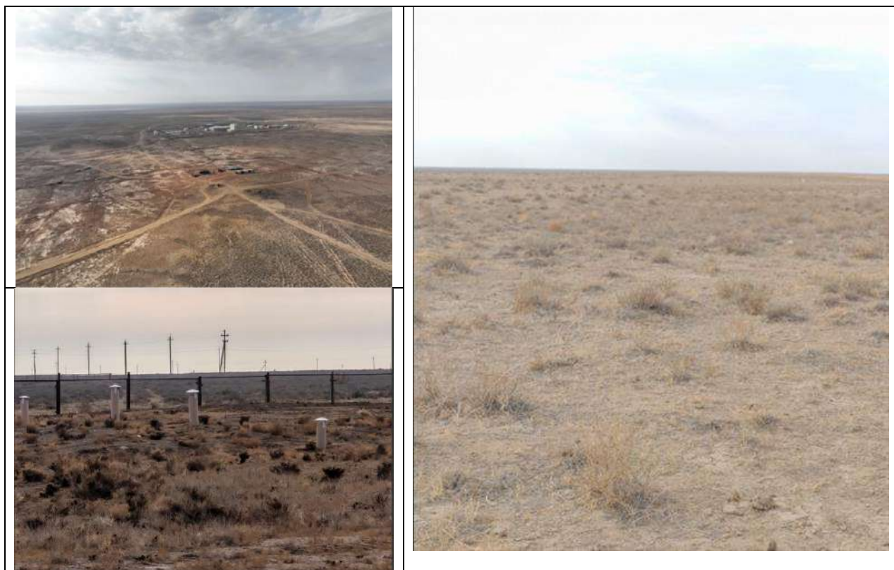
Рисунок 30 - Общий вид района работ в контуре прогрессивной ликвидации: промплощадка и прилегающая инфраструктура геотехнологического поля
