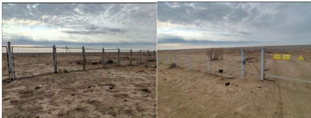
Рисунок 4 - Общий вид района работ в контуре прогрессивной ликвидации: промплощадка и прилегающая инфраструктура геотехнологического поля
